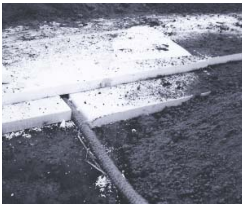
Toepassing drainageplaten.
