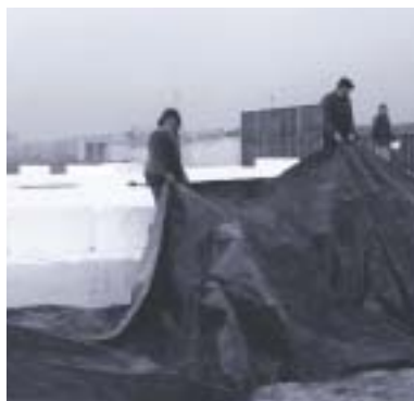
Afdekken met vloestofdichte folie.
